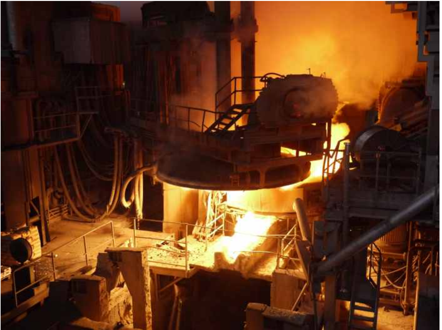
Zgoraj: dvig in odmik oboka EOP pred zalaganjem pe i z jeklenim odpadkom
