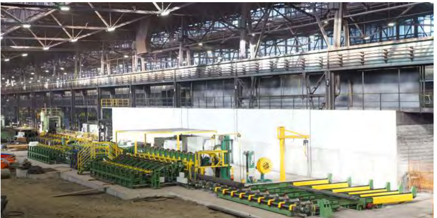
Zgoraj: Nova delovodska kabina adjustaže, Spodaj: montaža nove kontrolne linije
